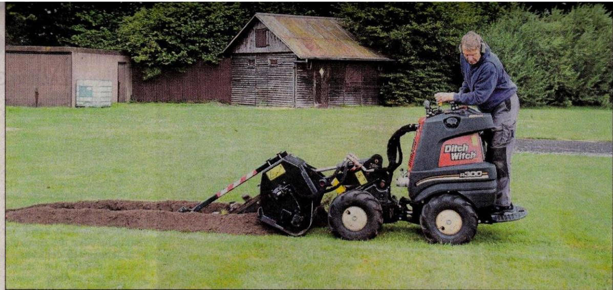
Mit einer Fräse wurden die engen Kanäle auf dem Sportplatz gegraben, in die die Rohrleitung verschwand.
