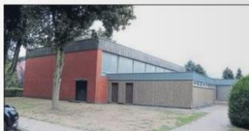
In der Sporthalle Drebber darf derzeit nicht geduscht werden. Der Grenzwert für Legionellen ist überschritten. ■ Foto: Reckmann
