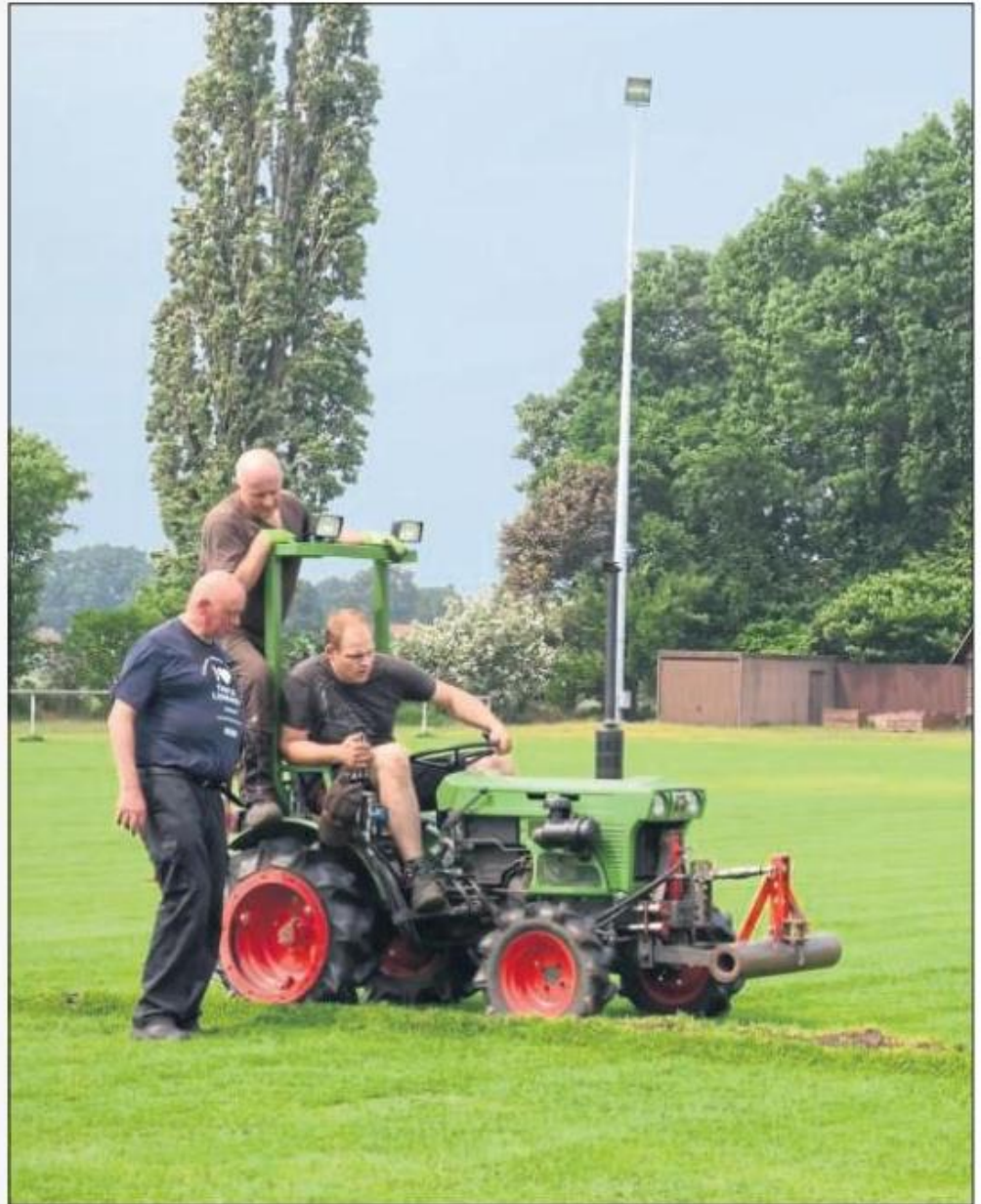
Auf dem Sportplatz laufen die vorbereitenden Arbeiten für den Aufbau der Videoleinwand. Dabei kann Vorsitzender Heinfried Maschmeyer (l.) auf die Unterstützung von Heiko und Hendrik Gröne aus Cornau bauen. Sie verlegen mit einem Spezialflug das Übertragungskabel. • Foto: TSV Drebber
