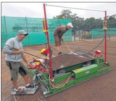
Innerhalb weniger Tage haben Mitarbeiter der Firma Sportas den pflegeleichten Kunststoffboden verlegt. • Foto: TSV Drebber
