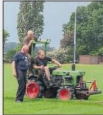
Auf dem Sportplatz wird ein Kabel für die Videowand verlegt.
